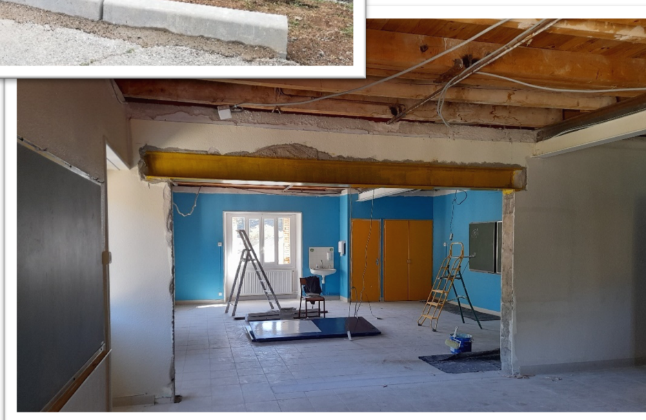
Ouverture pour agrandissement d'une salle de classe
