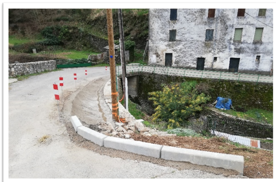
Travaux rue du Chazalet
