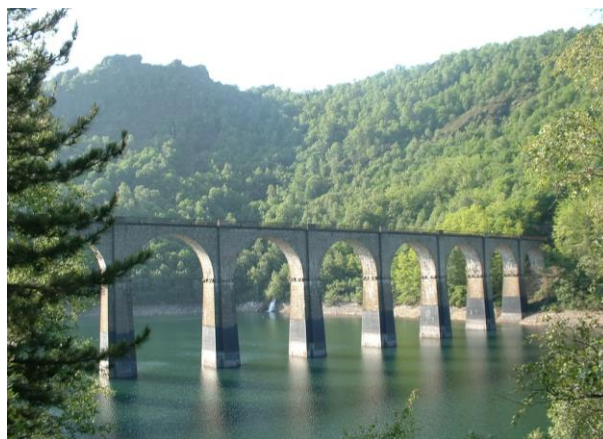
Le Viaduc de l'Altier, long de 257 m pour 72 m de haut.
