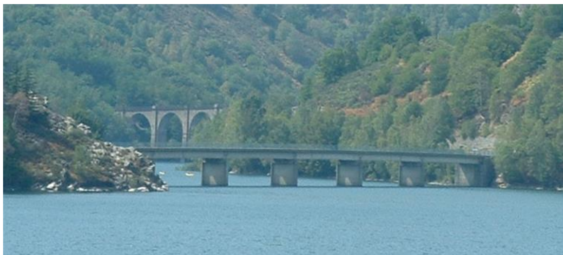
Superposition visuelle' des divers réseaux : La RD 901 et le chemin de fer au-dessus du plan d'eau.
