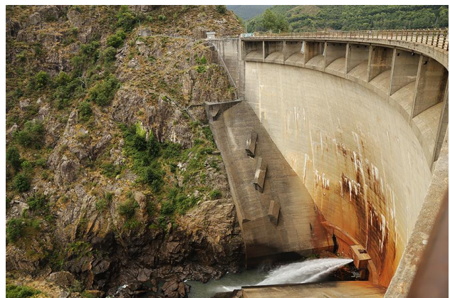
Barrage de Villefort
