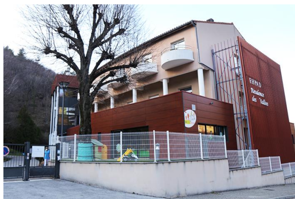
EHPAD La résidence des Vallées
