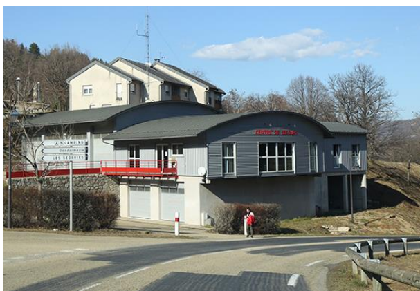
Centre de secours des pompiers
